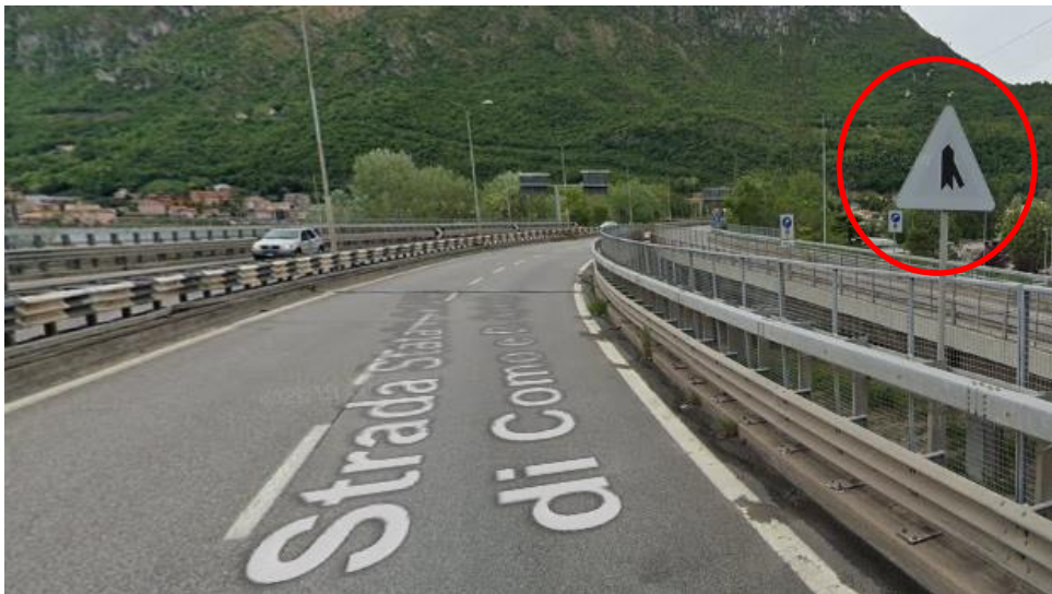
Esempio di segnale stradale verticale non pienamente visibile, in prossimità della rampa di immissione
