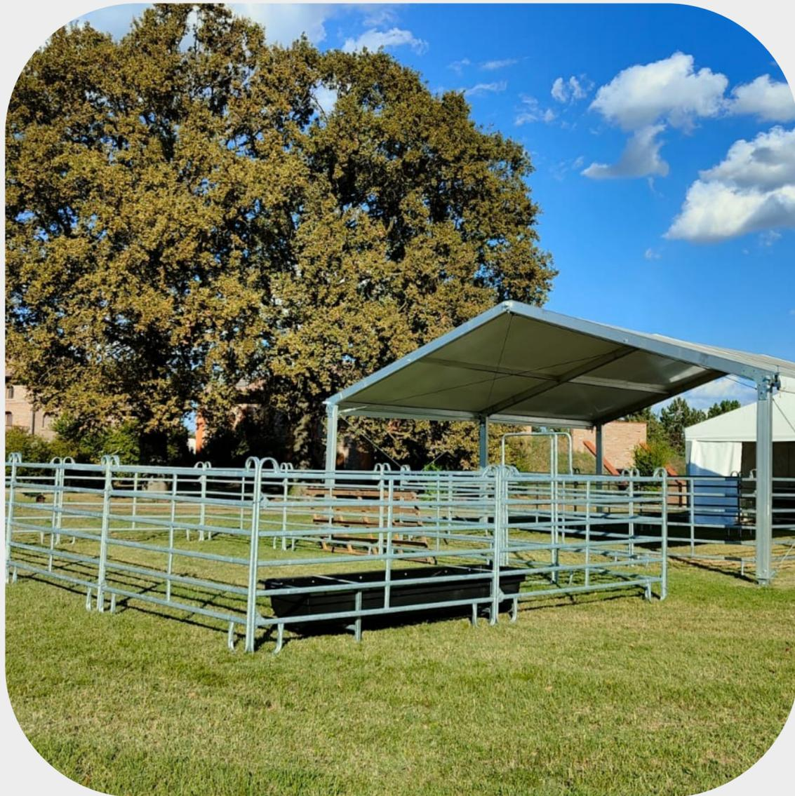
È una **tensostruttura modulare antineve (20x10)** per contenere fino a un massimo di **80 bovini o equini**, provvista di recinzione elettrificata e mangiatoie.
