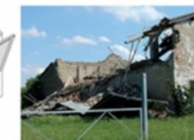
a2. Parete trattenuta da solaio interpiano (cerniera al solaio)
