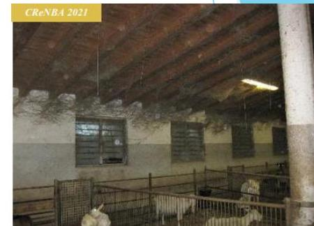
Figura 32 - Condizioni micro-climatiche non adeguate: le ragnatele sul soffitto testimoniano una scarsa circolazione d'aria.
