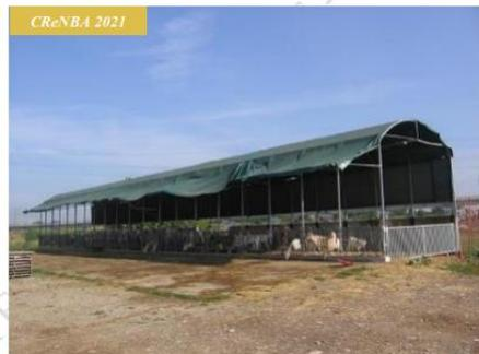
Figura 35 - Condizioni micro-climatiche adeguate: stalla munita di tende ombreggianti che proteggono dalla luce diretta del sole.
