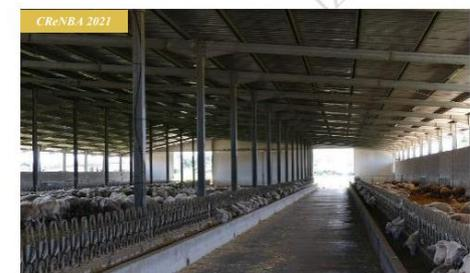
Figura 37 - Esempio di ventilazione naturale (stalla aperta): giudizio adeguato.
