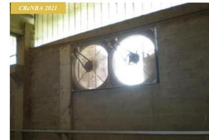
Figura 36 – Presenza di estrattori, utili a modulare la temperatura e l'umidità relativa all'interno della stalla. Se associati a sistemi automatici di controllo, potrebbero essere giudicati come ottimali.
